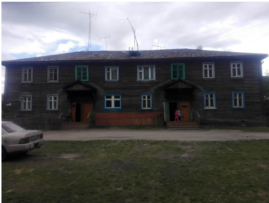
Фото В.1 – Главный фасад
