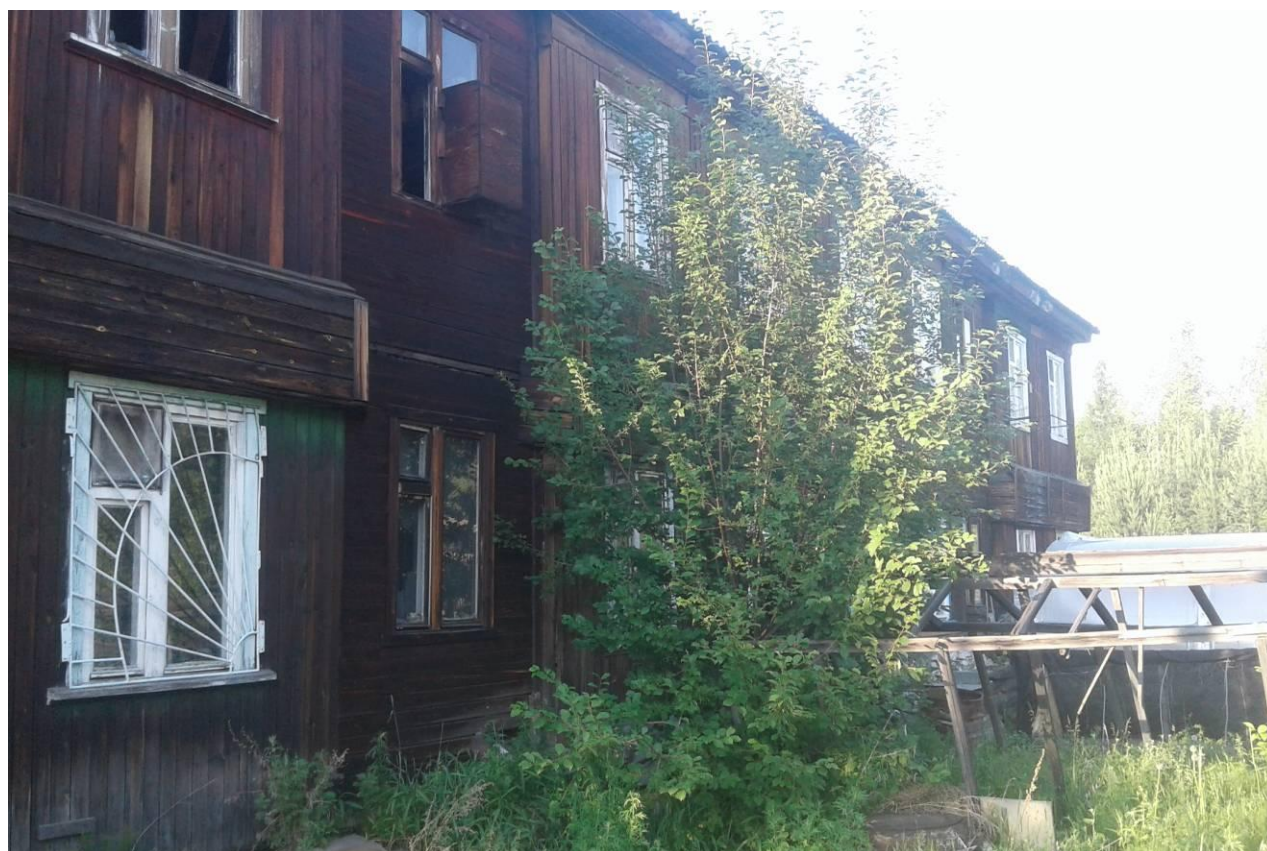
Фото В.2 – Дворовый фасад
