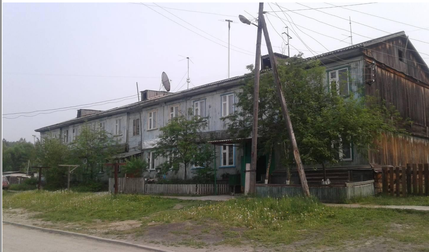
Фото В.2 – Дворовый фасад
