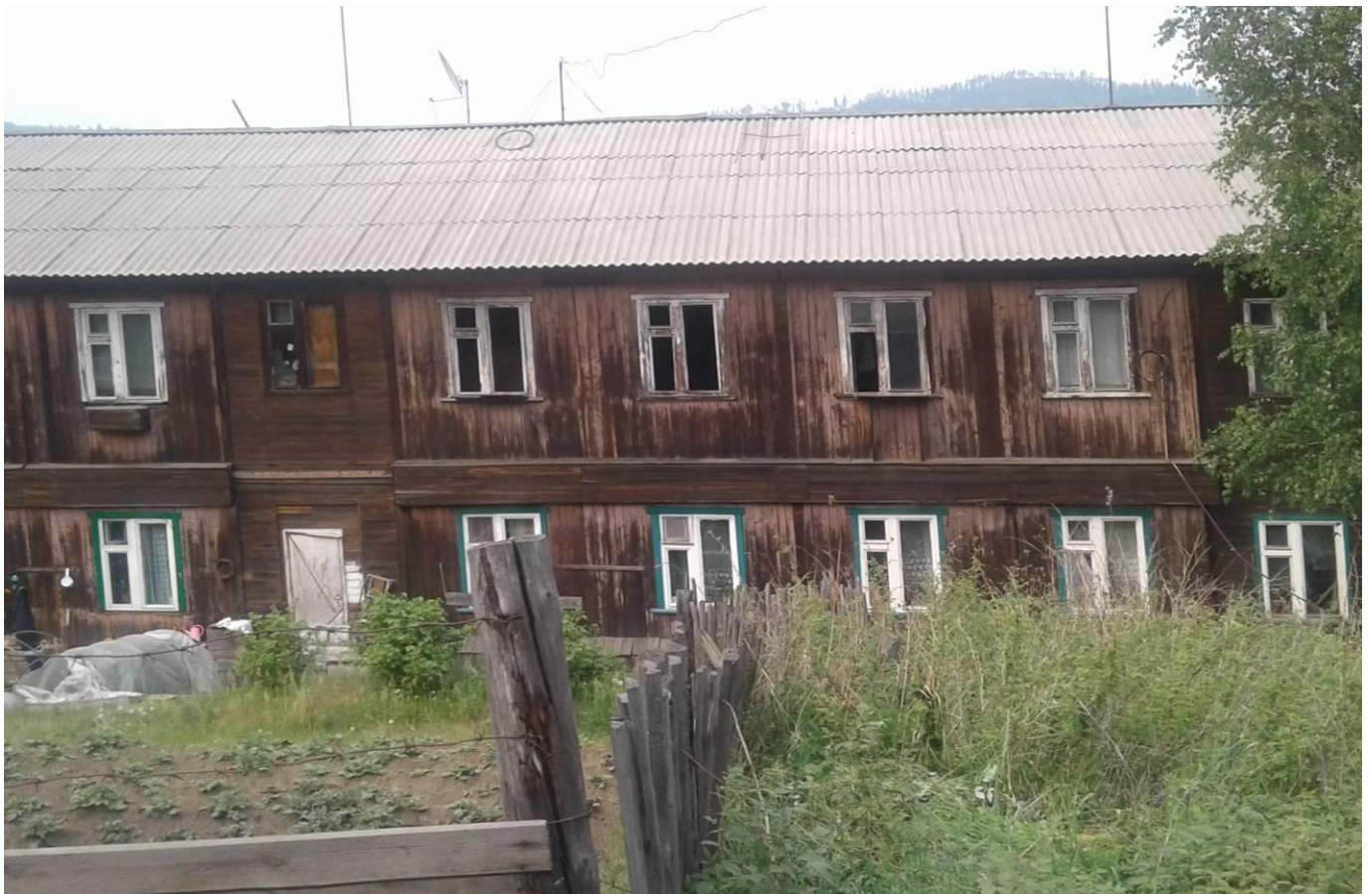
Фото В.2 – Дворовый фасад
