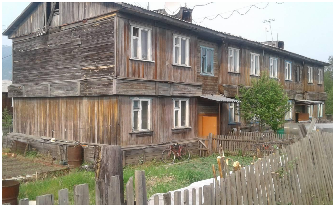
Фото В.2 – Дворовый фасад
