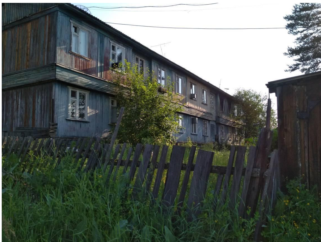
Фото В.2 – Дворовый фасад
