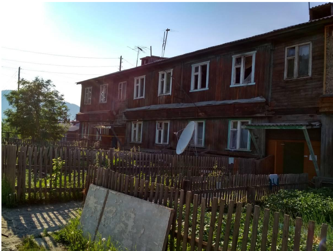
Фото В.1 – Главный фасад
