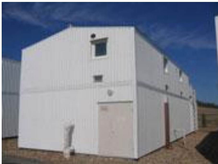
Рисунок 13.2 Внешний вид очистных сооружений «Биоресурс»
